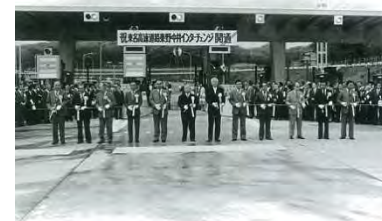
東名高速道路 秦野中井インターチェンジ完成
