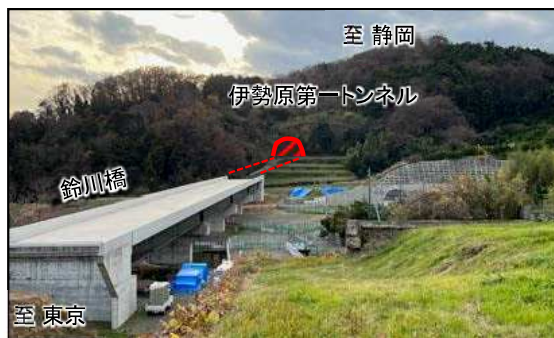
①【鈴川橋上部工(令和6年3月撮影)】
