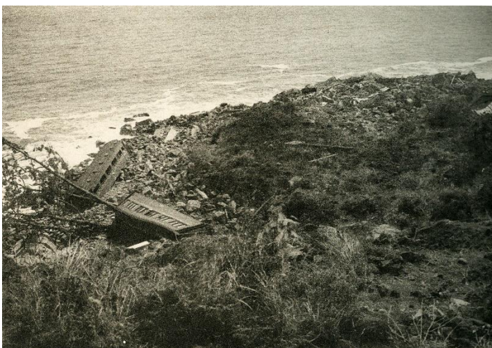
図 23 根府川では駅も地滑りで崩落しました（根府川駅付近其二（七台ノ内五台埋没セリ）） 大震災写真帳より
