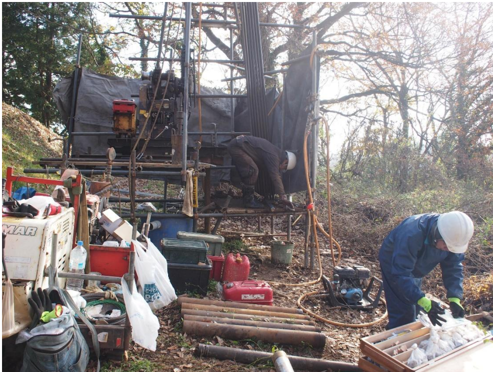
図 13 ボーリング調査のようす
